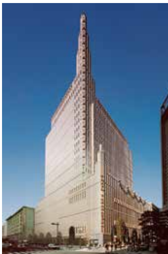
本社ビル(東京宝塚ビル12階) Head office (Tokyo Takarazuka Bldg. 12F)
