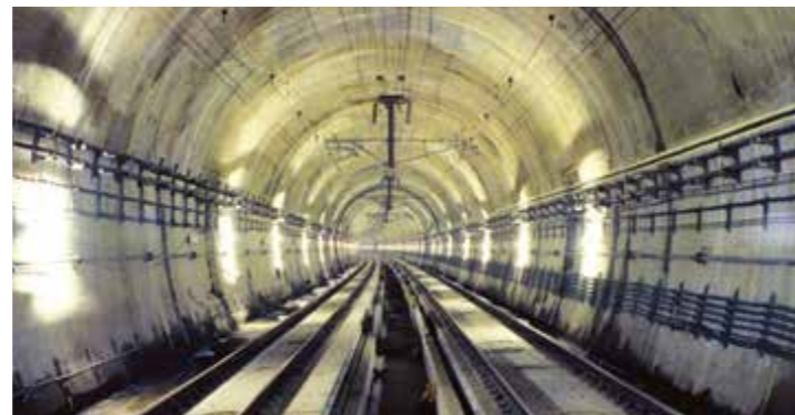
鉄道トンネル内 (AGF・セグメント他)
